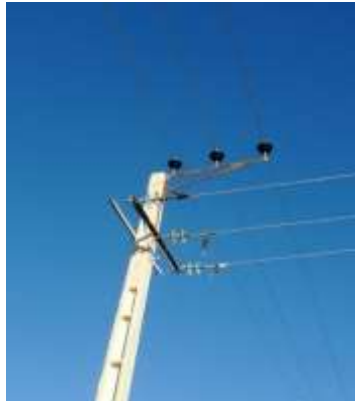
شکل ۱۰۰: آرایش گونیايي Bevel با کراس آرم بطول ۲۰۰ و باله ۷ سانتیمتر جدول ۱۲۵: مشخصات فنی و لیست کالا با آرایش گونیايي و با کراس آرم بطول ۲۰۰ و باله ۷ سانتیمتر
