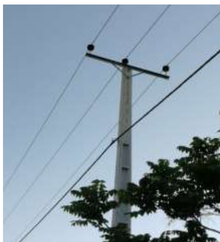
شکل ۹۲: آرایش T شکل با کراس آرم بطول ۲۰۰ و باله ۷ سانتیمتر
