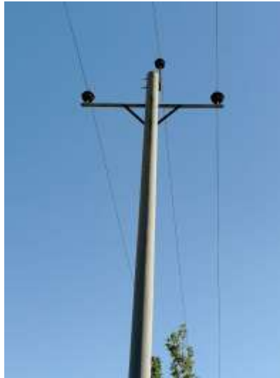
شکل ۱۰۹: آرایش T شکل با کراس آرم بطول ۲۰۰ و باله ۸ سانتیمتر
