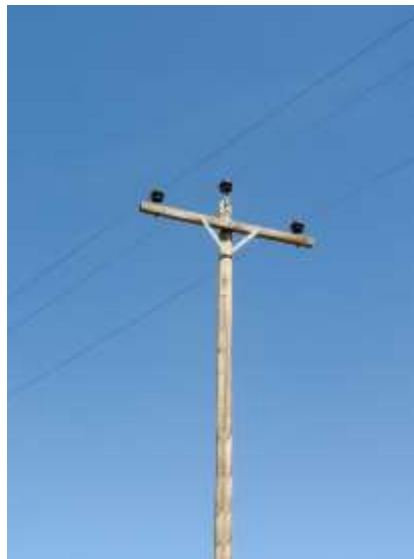
شکل ۱۱۰: TW آرایش T شکل با کراس آرم چوبی (Wood) بطول ۲۴۰ و باله ۱۰ سانتیمتر
