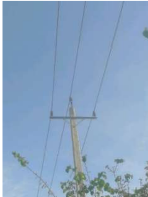
شکل ۸۹: آرایش T شکل با کراس آرم بطول ۲۰۰ و باله ۸ سانتیمتر
