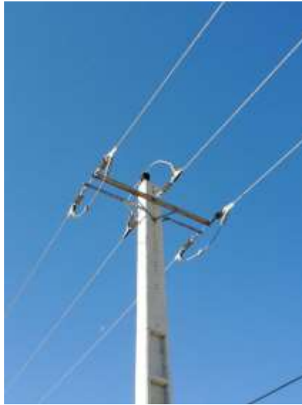
شکل ۹۱: آرایش T شکل با کراس آرم بطول ۲۰۰ و باله ۸ سانتیمتر
