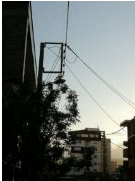
شکل ۱۰۷: آرایش P شکل با ۵ اتریه و کراس آرم به طول ۹۰ و باله ۷ سانتیمتر
