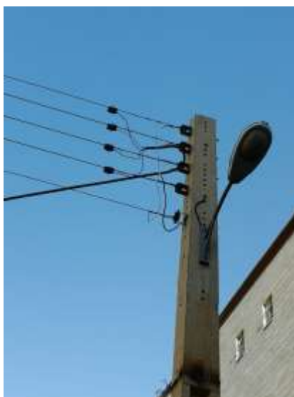
شکل ۱۰۶: آرایش CL با ۵ اتریه
