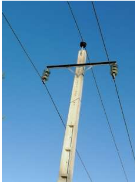
شکل ۹۰: آرایش T شکل با کراس آرم بطول ۲۰۰ و باله ۸ سانتیمتر
