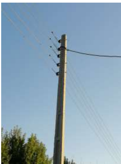
شکل ۱۰۵: آرایش CL با ۵ اتریه
