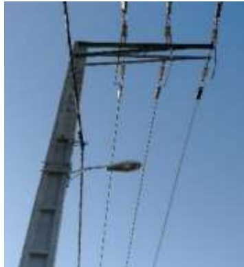
شکل ۹۸: آرایش F شکل با کراس آرم بطول ۲۴۰ و باله ۸ سانتیمتر
