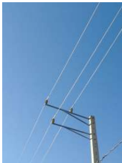
شکل ۹۵: آرایش 2F شکل کراس آرم بالایی بطول ۲۴۰ و کراس آرم پایینی بطول ۲۰۰ و باله ۸ سانتیمتر
